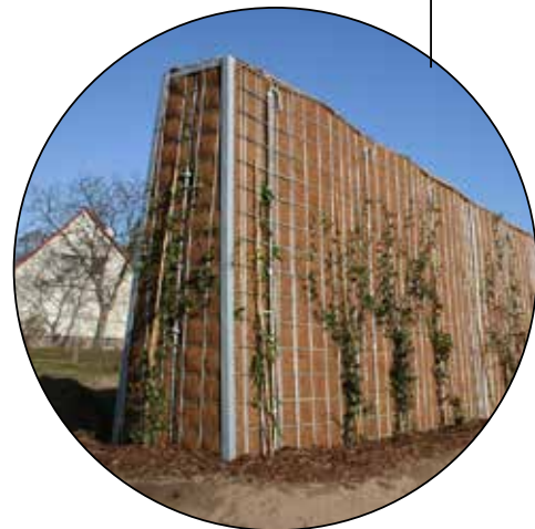
zelená akustická stěna při výstavbě
